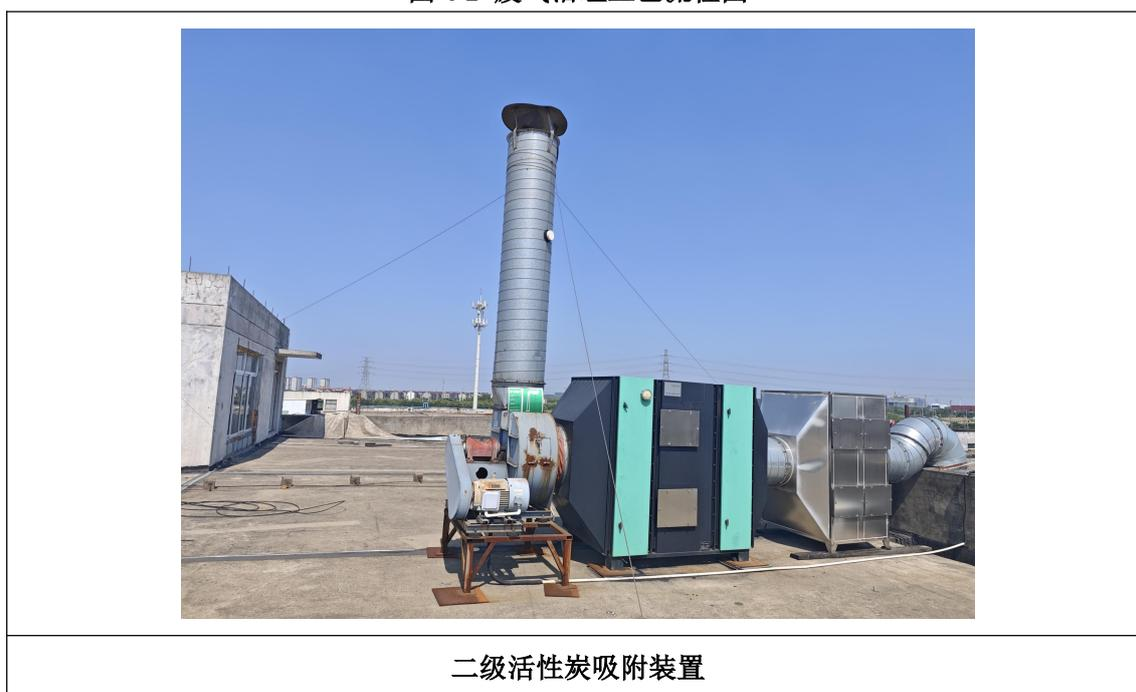
图 4-3 部分废气处理设施图
