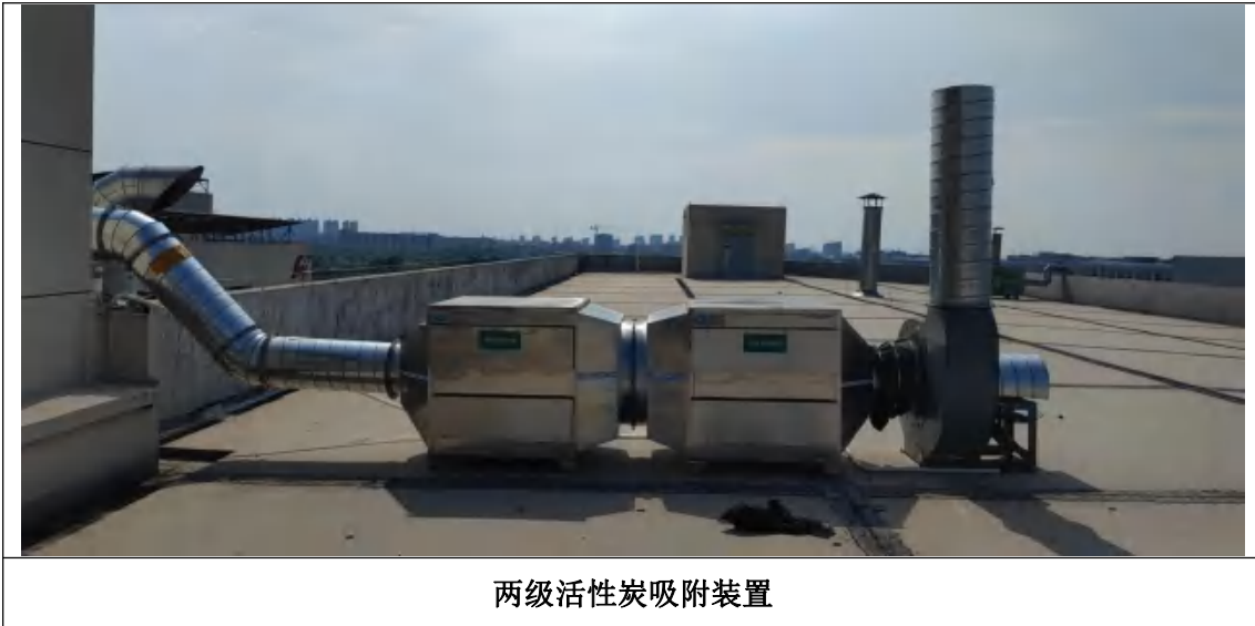
图 4-2 部分废气处理设施图
