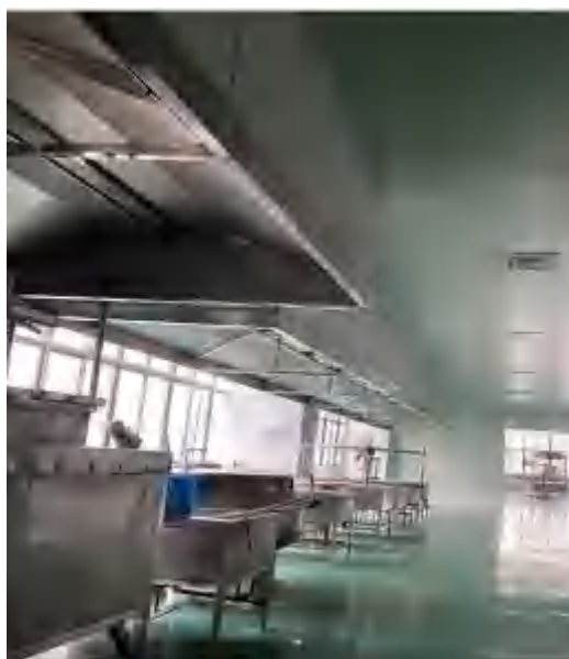
调和杀菌、蒸煮废气集气罩
