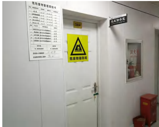
危废标识+危废周知卡+双人双锁+消防设施
