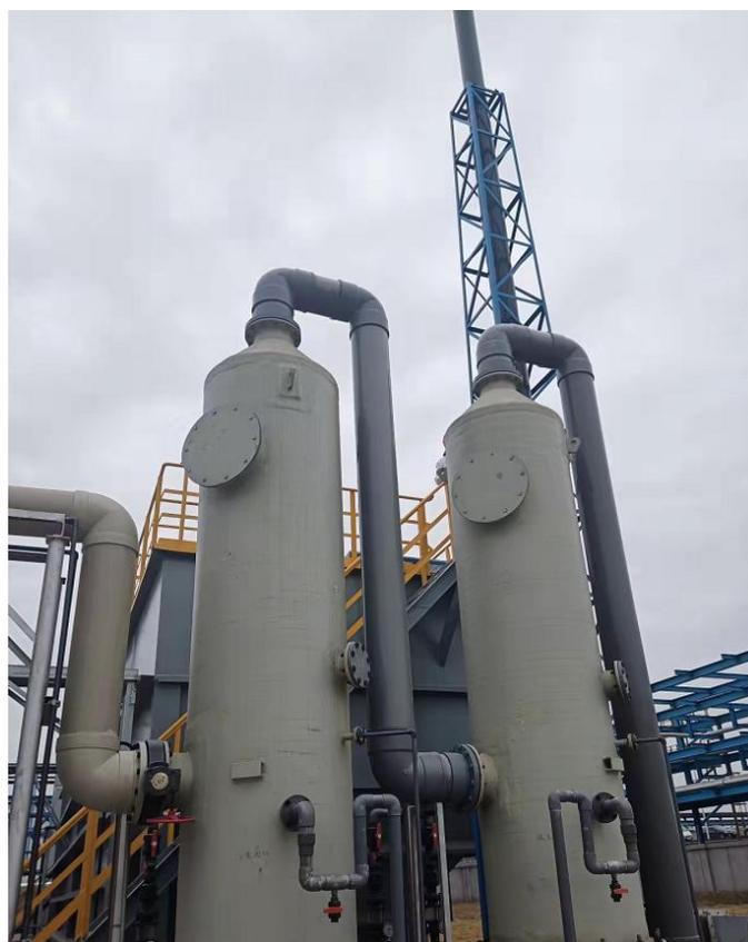
次氯酸钠喷淋+碱液喷淋废气处理设施
