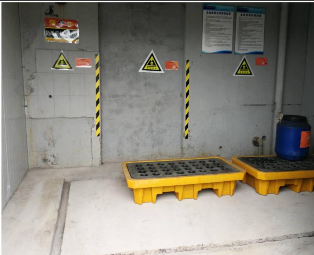
危废管理制度+危废标识+防渗漏托盘+导流槽
