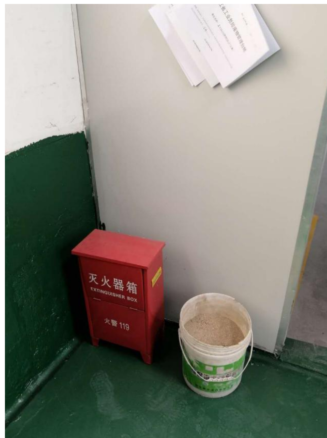
消防设施+导流沟
