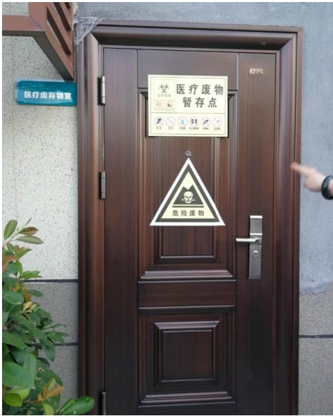
医疗废物暂存间
